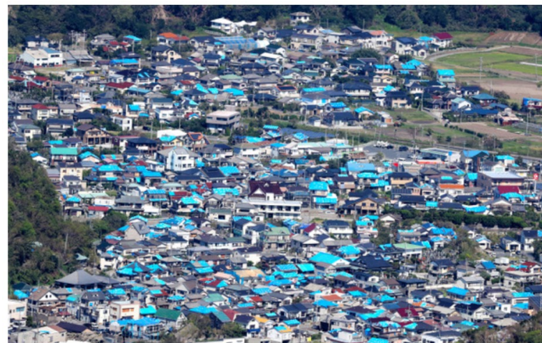
台風15号の被害を受けた地域（千葉県）
